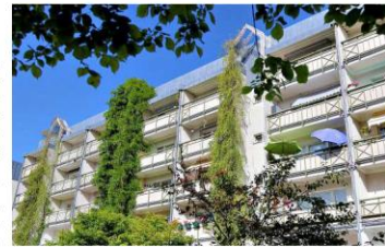
Anbauten an den Fassaden der Petrowskaja-Straße: Mit der Begrünung hat es nicht an allen Aufgängen geklappt. FOTO: SIMON VOIGT
