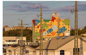
Fassade als Kunstwerk: Das Phönixhaus ist ein Beispiel für farbenfrohe Sanierung. FOTO: SIMON VOIGT
