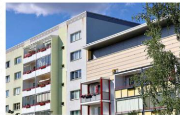
Ein paar Etagen runter, ein hübscheres Dach rauf: Schon wird aus der Platte ein ganz neues Gebäude, wie hier in der Oststadt. FOTO: SIMON VOIGT
