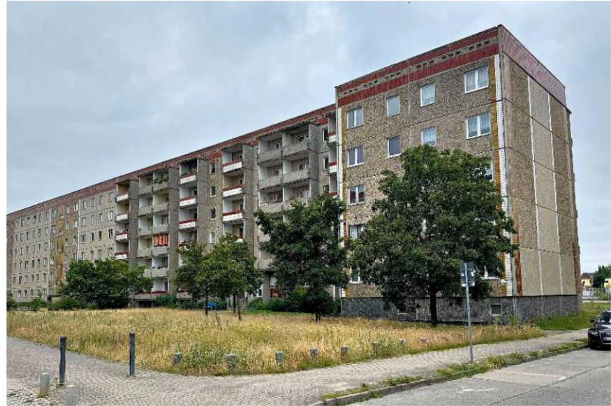
Die beiden äußeren Gebäude sollen abgerissen werden.
