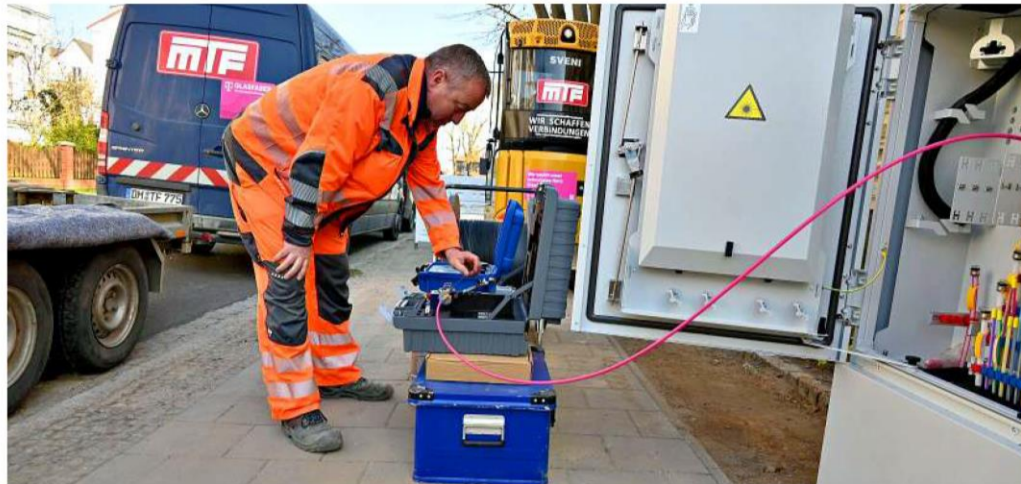
Sven Rohde aus Gültz hat im Neubrandenburger Jahnviertel für die Telekom das erste Glasfaserkabel durch neu verlegte Rohre eingeblassen.
