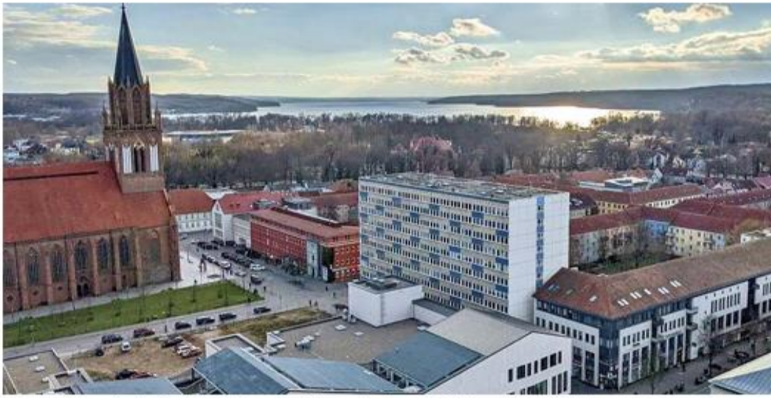
Das Hochhaus in der Neubrandenburger Waagestraße wird nicht mehr lange stehen.
