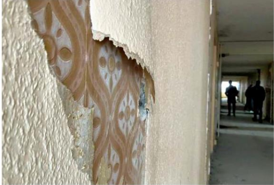
In den leergeräumten Fluren erinnern alte Tapeten noch an Einrichtungsmoden vergangener Zeiten.
