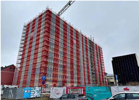
Nur noch ein paar Tage, dann schweben die ersten meterlangen Betonplatten am Kran von der 11. Etage gen Boden.
