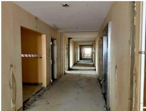
55 Meter lang war die „Wohnscheibe“. Kurz vor dem Abriss sind die Flure komplett entkernt.
