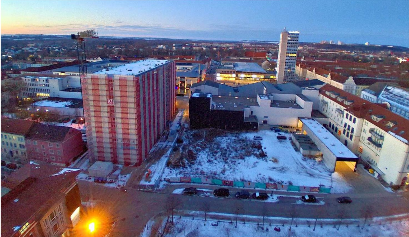
Dieser Ausblick von der Konzertkirche in Richtung Marktplatz wird bald etwas freier sein: Das schon eingerüstete Wohnhochhaus in der Waagestraße wird jetzt abgerissen.
