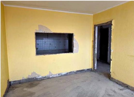
Blick vom Wohnzimmer zur Küche: Die typische Durchreiche ermöglichte es den Bewohnern ein schnelles Auf- und Abdecken.
