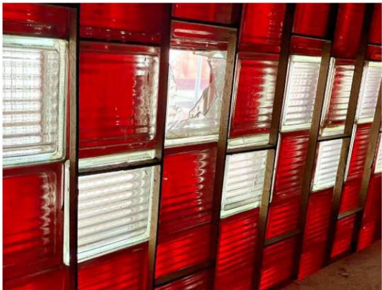
Die für Plattenbauten typischen Glassteine zieren die Treppenhäuser der „Wohnscheibe“.
