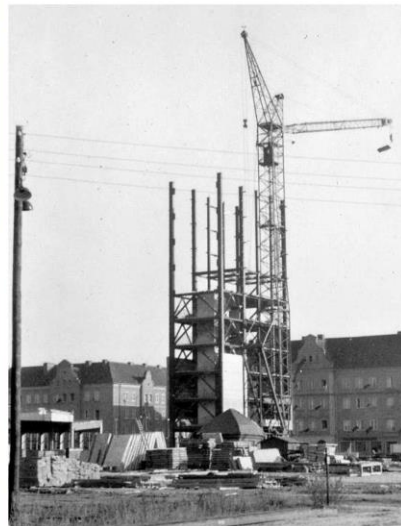
Der Neubau schritt schnell voran, doch noch stand das Trafo-Häuschen.
