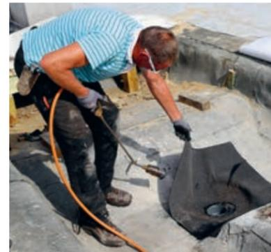
Besonders herausfordernd ist die Baumaßnahme auf dem Dach, weil das Wetter zum Zeitpunkt der Arbeiten wechselhaft ist. Von 40 Grad bis hin zum Sturzregen - hier muss schnell gehandelt werden. Deswegen wird immer nur partiell ein Teil des Daches aufgenommen und noch am selben Tag verschlossen.
