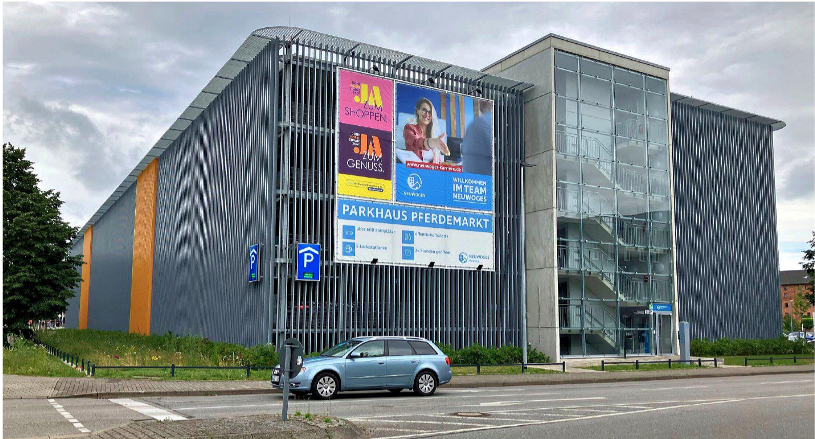
Der Bau des im Mai 2022 fertiggestellten Parkhauses am Pferdemarkt in Neubrandenburg hat etwa zehn Millionen Euro gekostet. FOTO: LISA GUTZAT
