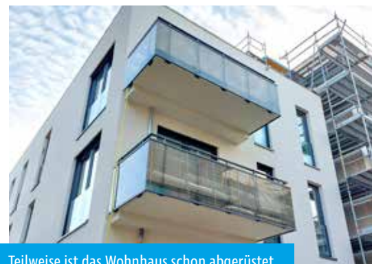
Teilweise ist das Wohnhaus schon abgerüstet.
