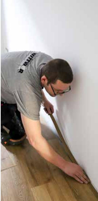
Feinschliff beim Verlegen der Fußböden.
