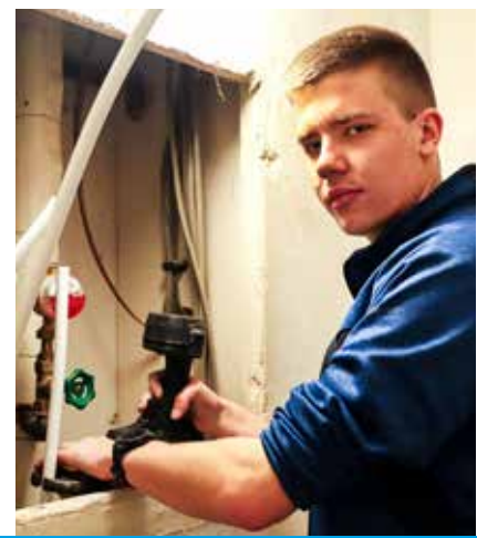
Zu den Aufgaben des 21-jährigen Louis Schwebs gehört auch das Installieren von Wasserversorgungssystemen.
