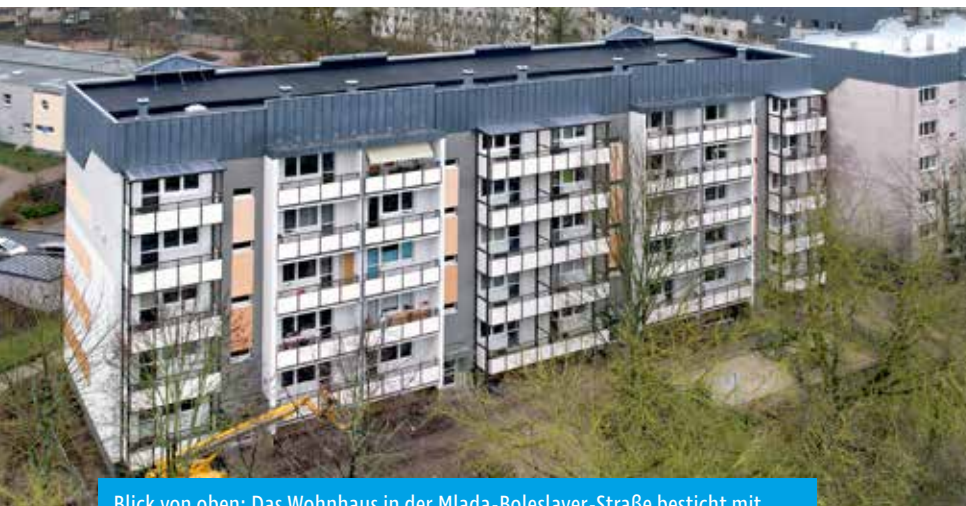
Blick von oben: Das Wohnhaus in der Mlada-Boleslaver-Straße besticht mit neuer Fassade und Balkonen, deren Dächer rechts im Bild montiert werden.
