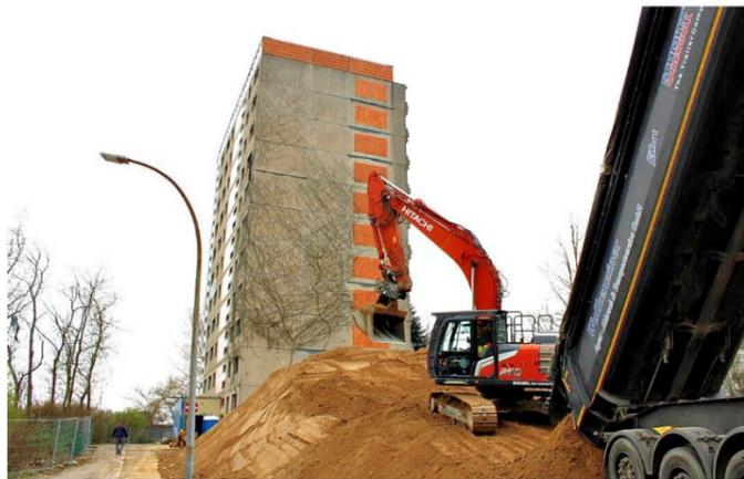
Damit der Abrissbagger bis ganz oben ans elfte Geschoss kommt, wurde mit mehreren Tausend Tonnen Sand eine Rampe aufgeschüttet in der Villejuifer Straße. FOTO: MIRKO HERTRICH
