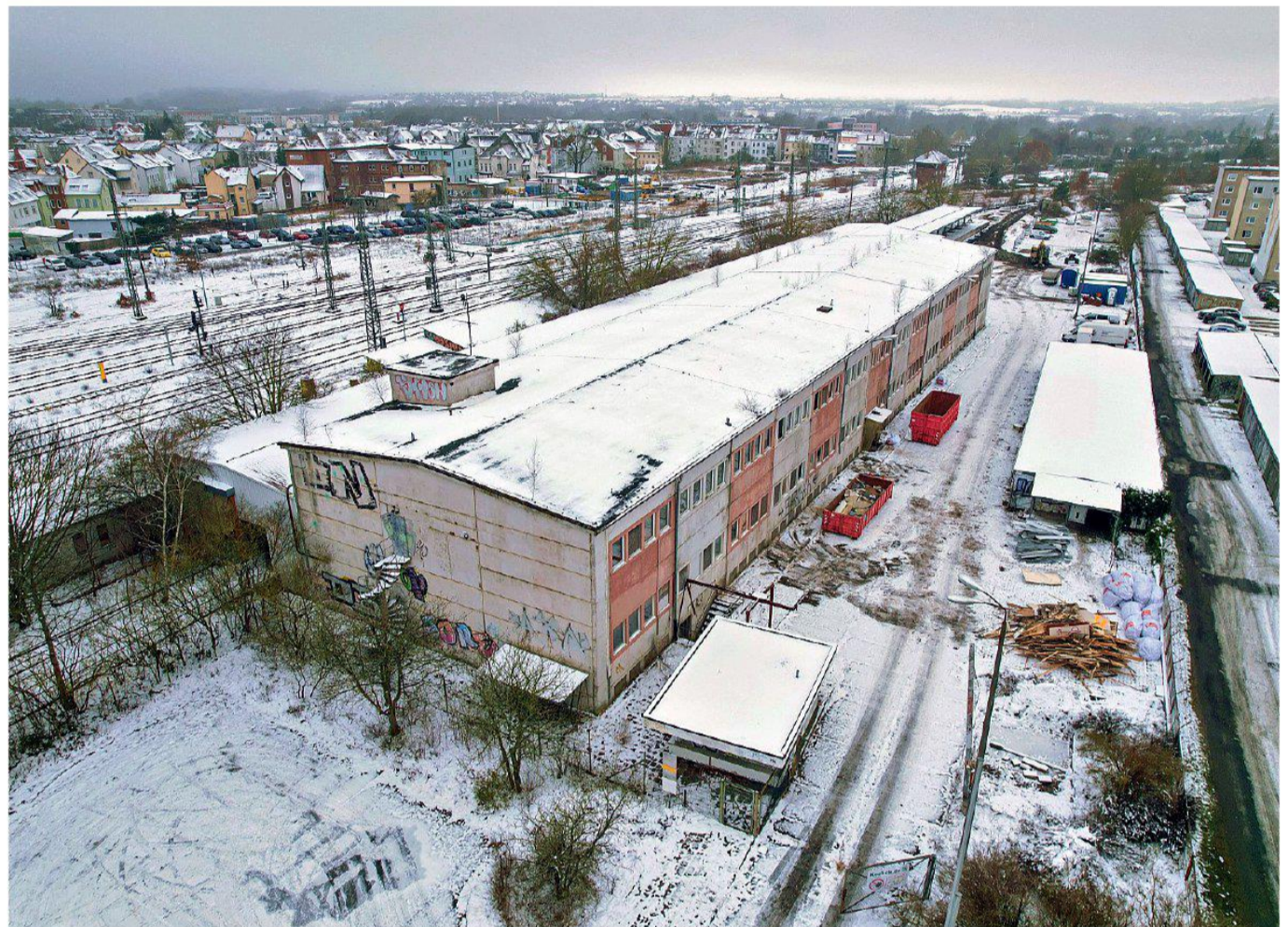
Das Bahnpostamt in der Greifstraße nördlich des Neubrandenburger Bahnhofs wird es bald nicht mehr geben. Anfang Januar begannen die Arbeiten zum Rückbau. FOTO: MIRKO HERTRICH
