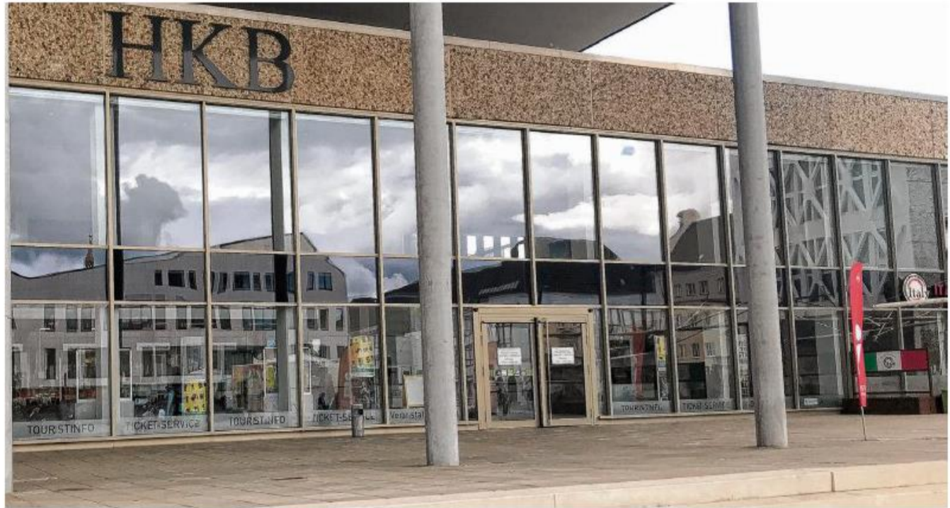
Im Sommer 2021 hat die Neuwoges Kameras für eine Videoüberwachung der Terrasse vor dem HKB installiert. Nach einer Auflage dürfen sie aber nur von 23 bis 6 Uhr aufzeichnen. FOTO: MIRKO HERTRICH
