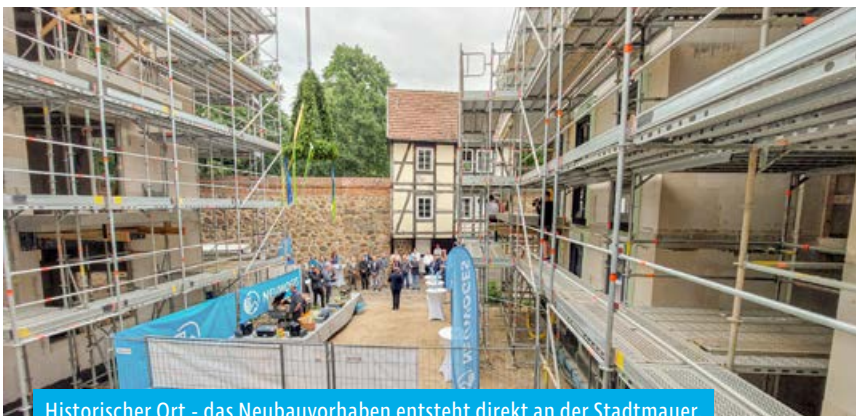
Historischer Ort - das Neubauvorhaben entsteht direkt an der Stadtmauer.
