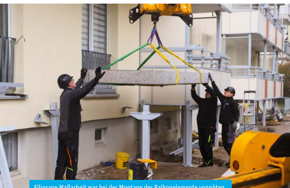
Filigrane Maßarbeit war bei der Montage der Balkonelemente vonnöten.
