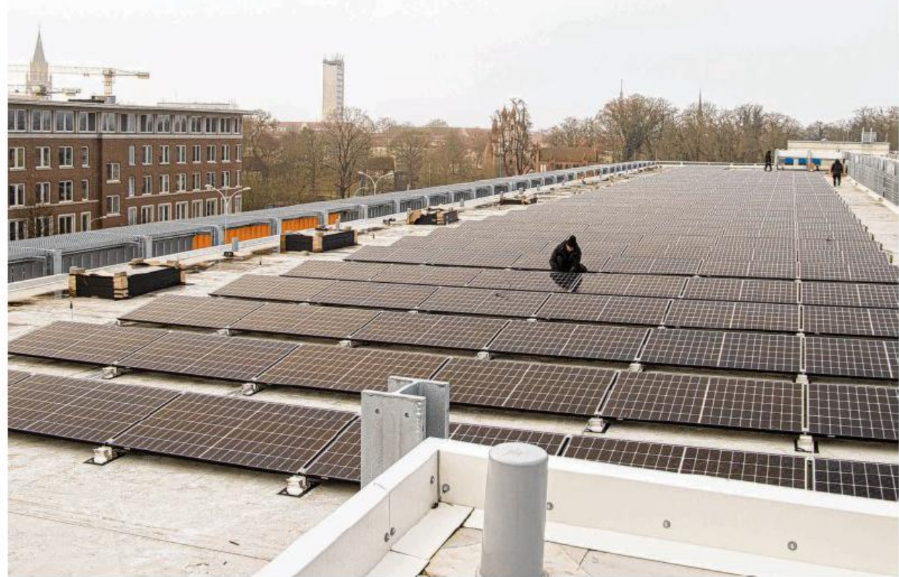
Aktuell montieren Fachmänner 750 Photovoltaikmodule auf dem Dach des Parkhauses am Pferdemarkt. Das wäre die 85. Solaranlage, die Strom für die Neuwoges produziert. FOTO: ZVG/NEUWOGES
