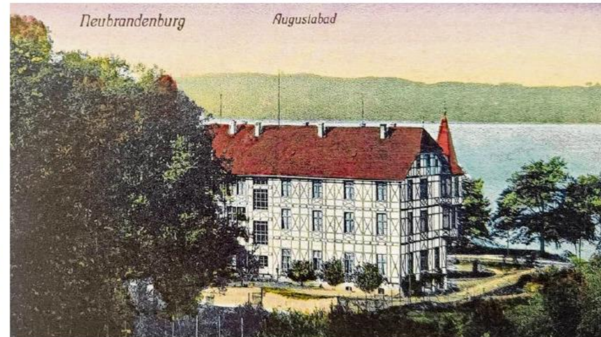
Das Kurhotel Augustabad - 2005 wurde der Bau nach Jahren des Leerstandes abgerissen. Seitdem wurde um eine neue Bebauung immer wieder gerungen. REPRO; ZVG/M. HERTRICH
