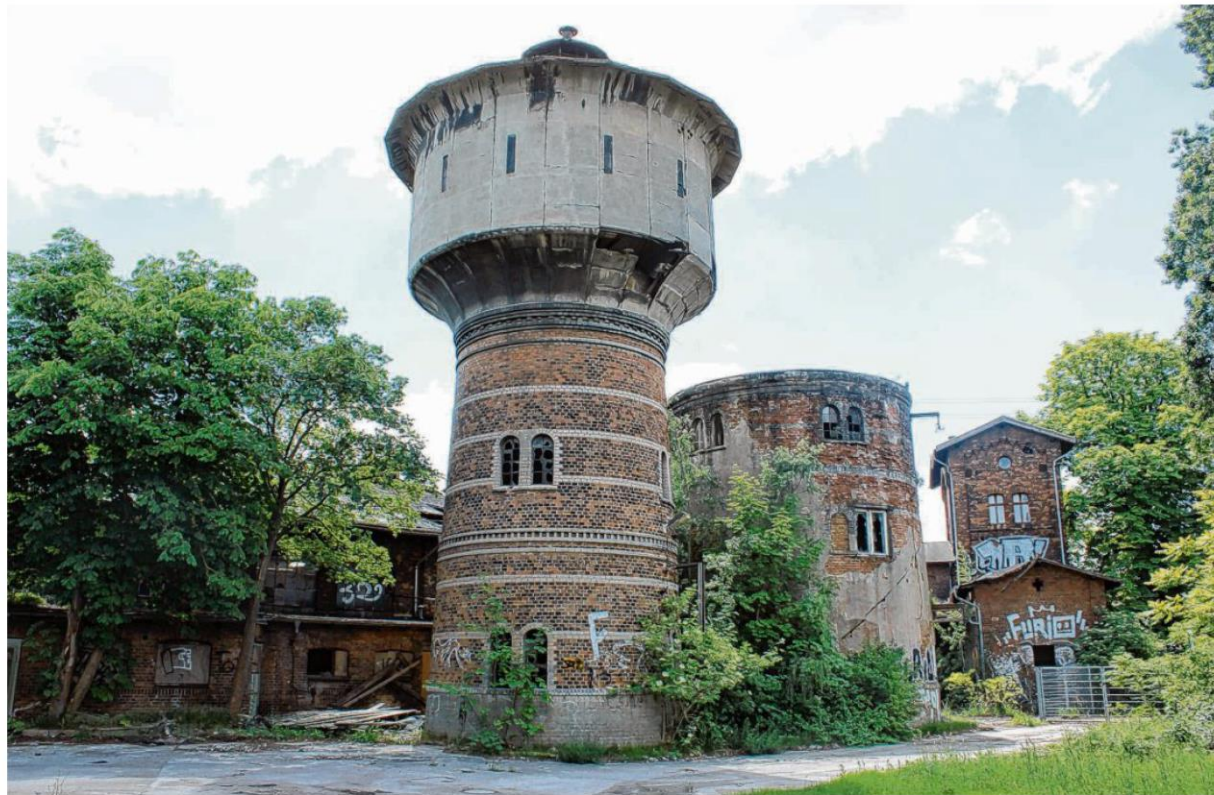
Auf dem alten Lokschuppen-Areal sollen schon bald kluge Köpfe für Innovationen sorgen.
