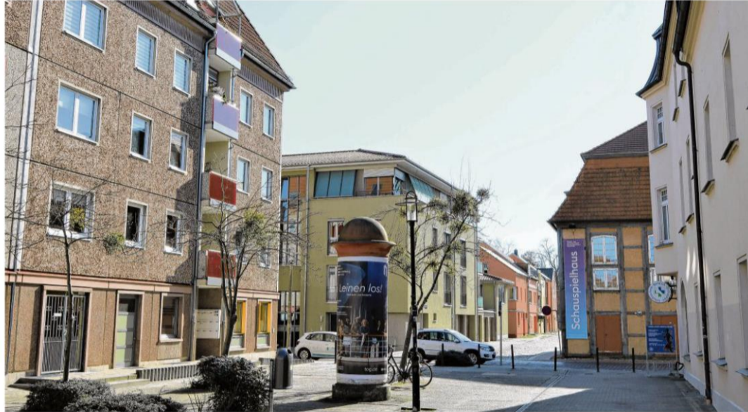
Für eine Drei-Raum-Wohnung in der Behmenstraße am Schauspielhaus in der Neubrandenburger Innenstadt läuft eines der beiden ersten öffentlichen Bieterverfahren der Neuwoges gegen Höchstgebot. Das Mindestgebot liegt bei 93 700 Euro. FOTO: SIMON VOIGT
