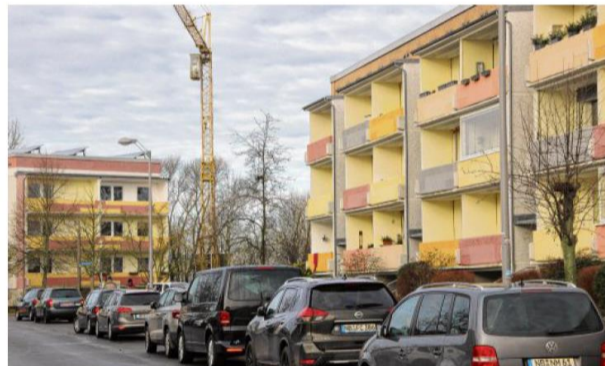
Auf dem Datzeberg sind von den ehemaligen Fünfgeschossern schon längst zwei Etagen abgerastert worden. FOTOS: THOMAS BEIGANG
