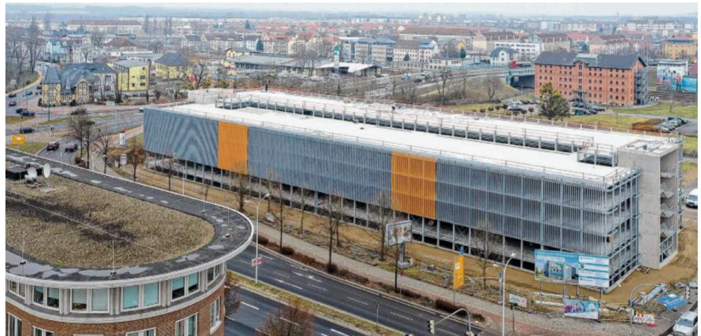
Das neue Parkhaus am Pferdemarkt ist fast 15 Meter hoch und knapp 100 Meter lang. 600 Autos sollen dort Platz finden. Früher stand hier das Günter-Harder-Stadion.
