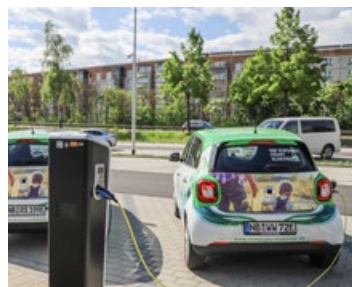
Auf dem Parkplatz Tilly-Schanzen-Straße stehen vier neue Ladesäulen.
