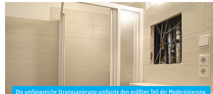
Die umfangreiche Strangsanierung umfasste den größten Teil der Modernisierung.
