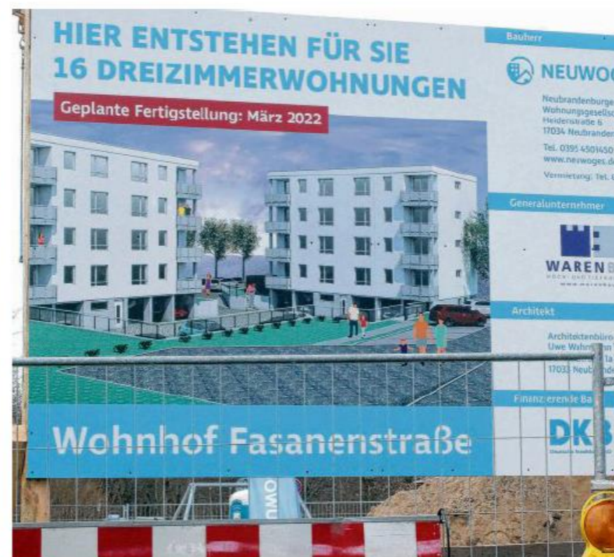
Für rund 2,6 Millionen Euro baut die Neuwoges bis zum 1. Quartal des kommenden Jahres zwischen Vogel- und Reitbahnviertel insgesamt 16 neue Mietwohnungen für ihren Bestand.
