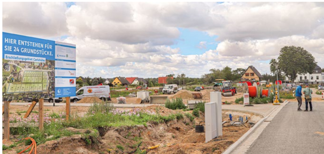
Im Frühjahr starteten die Erschließungsarbeiten in der Kieseestraße von Neubrandenburg.
