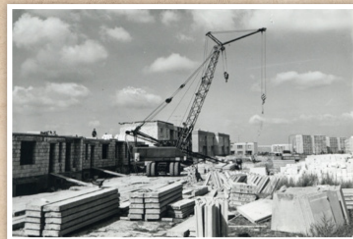
Auf der Baustelle am Kiessee: Hier werden Eigenheime entstehen. (Foto: Stadtarchiv)
