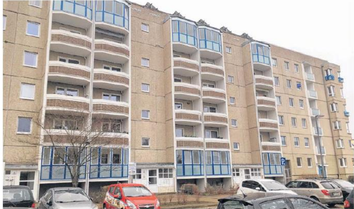
Zahlreiche Balkone sind in der Brodaer Straße modernisiert worden – nicht zur vollen Zufriedenheit einer Mieterin, die dann auch noch ein Spülkasten-Problem bekam.
