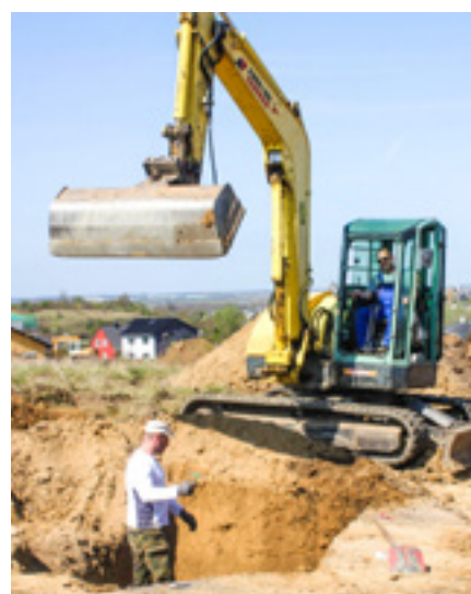
Steep – 3. Bauabschnitt Nord
