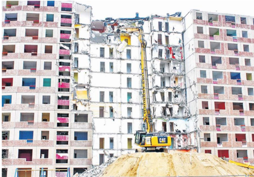
Dieser Elfgeschoss wurde ab Herbst 2015 abgerissen, das schaffte Platz für neue Ideen.
