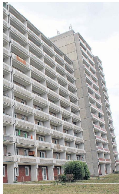
Zu den Neubaublöcken in der Neustrelitzer Straße wird die Polizei des Öfteren gerufen. Deutsche und ausländische Mieter gerieten aneinander.
