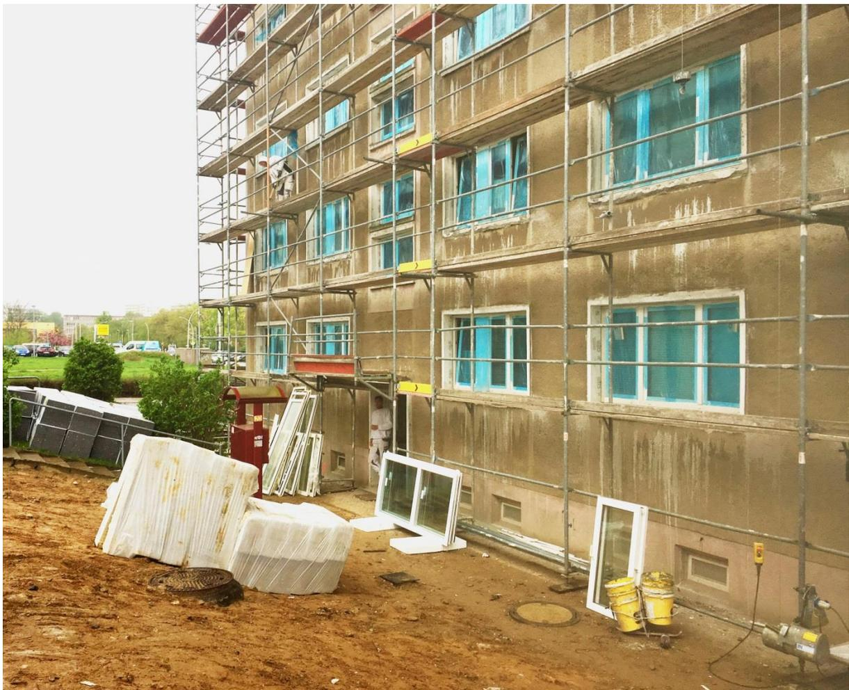
Die 45 Zwei-Raum-Wohnungen werden in Teilbereichen modernisiert und instandgesetzt. Die Ver- und Entsorgungsleitungen werden ausgewechselt, die Elektroinstallation teilweise und die Heizungsanlage komplett erneuert. Die Bäder werden neu gefliest und im Erdgeschoss mit bodengleichen
