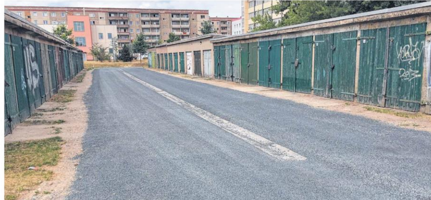
In diesem Garagenkomplex an der Adlerstraße hat die Neuwoges eine neue Fahrbahndecke aufbringen lassen.
