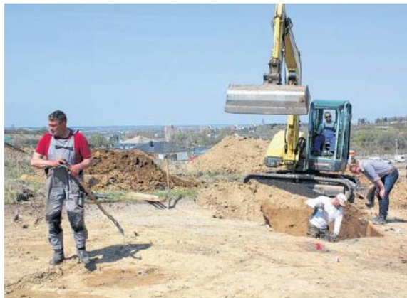
Die Erschließungsarbeiten für den 3. Bauabschnitt am Steep haben begonnen. Aber sie werden teurer als erwartet. FOTO: JÖRG FRANZE
