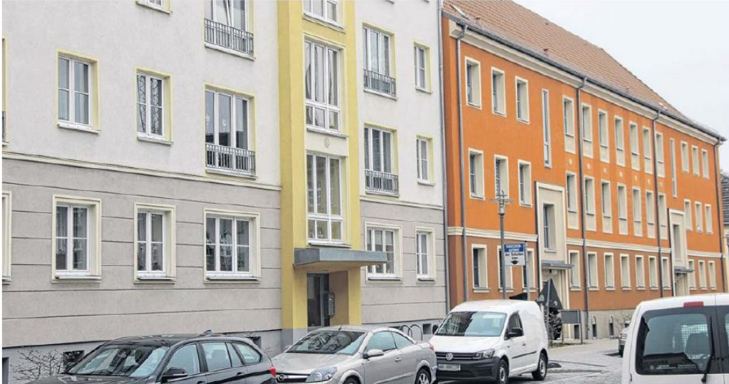
In mehr als 1500 Wohnungen - wie hier in der Darrenstraße - hat die Neuwoges schon eine neue Technologie zur Heizungsregulierung eingebaut. Darüber sind aber nicht alle Mieter begeistert.
