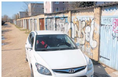
Auch dieser Komplex direkt neben der Fußgängerbrücke „Hahnentritt“ ist betroffen.
