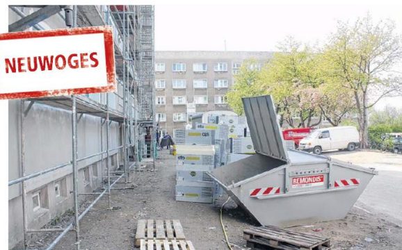
Die Neuwoges will die Sanierung im Karree Humboldtstraße 1-17 in diesem Jahr abschließen.
