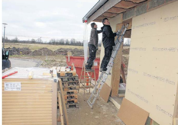
Torsten (rechts) und Michael Dryba bauen am derzeit letzten Haus in der Kessinerstraße. Dahinter haben aber schon die Arbeiten zur Erschließung des nächsten Abschnitts im Wohngebiet am Steep begonnen.
