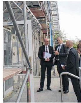
Neuwoges-Geschäftsführer Frank Benischke (2. von links) zeigt Minister Pegel (links) den neuen Eingangsbereich und die barrierefreie Rampe in der Ziolkowskistraße 9-11.
