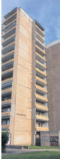
Auf dem Datzeberg ist die Zastrow-Straße 12/14 betroffen.
