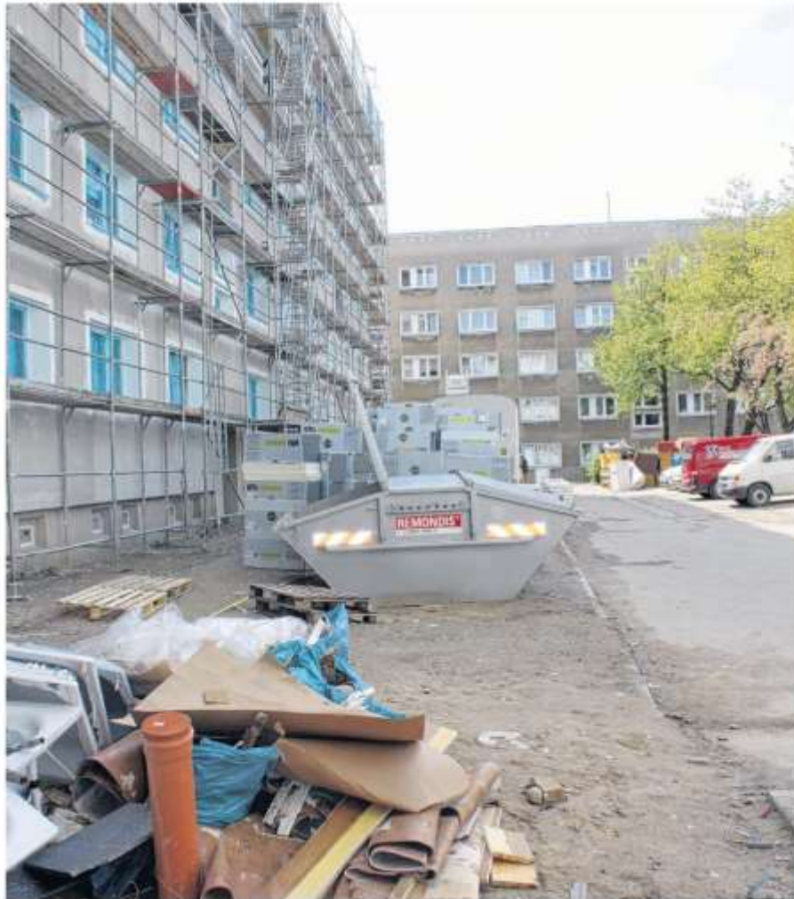
Im Haus links sind die Bauarbeiter seit einigen Tagen bei der Arbeit. Der Block im Hintergrund soll im kommenden Jahr angepackt werden.
