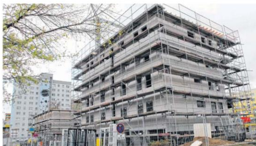
Die ersten beiden neuen Häuser in der Gaußstraße, wo einst Plattenbauten das Bild bestimmten, sollen Mitte Mai Richtfest feiern.
