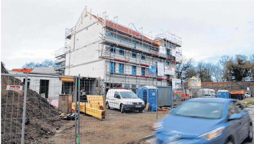
Wohnungen in der Innenstadt entstehen gerade hier in der Beguinenstraße, unweit der historischen Wallanlage.
