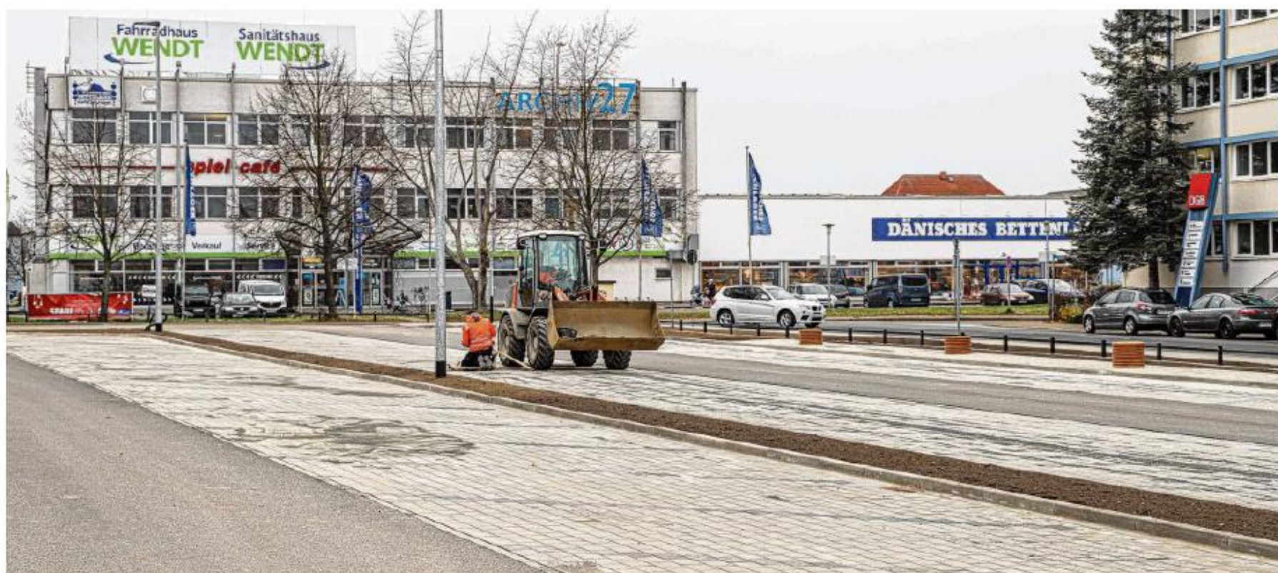
Auf dem neuen Parkplatz an der Tilly-Schanzen-Straße werden noch Restarbeiten ausgeführt. Morgen kann er aber schon genutzt werden.
