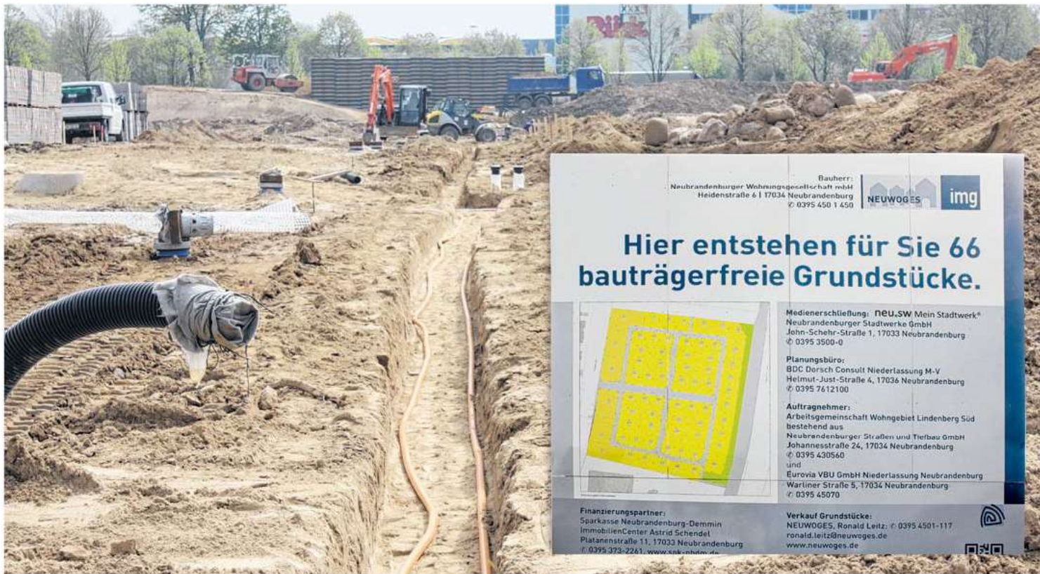
Die Erschließung des Baugebietes auf dem Lindenberg Süd zieht sich hin. Der Regen der vergangenen Wochen hat den Terminplan über den Haufen geworfen. FOTOS (2): ANKE BRAUNS
