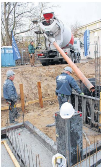
Beton, frisch aus dem Mischer - dann konnte die Kapsel für die Grundsteinlegung in der Gaußstraße versenkt werden.
